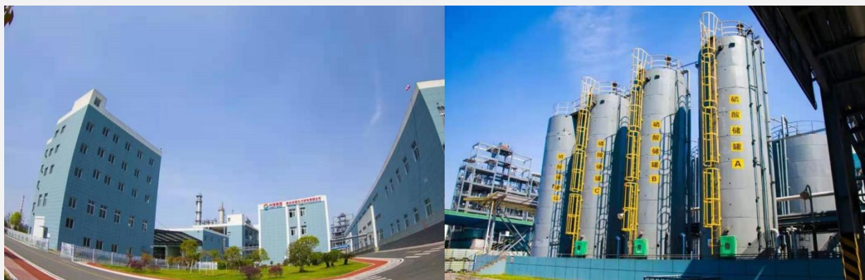
▲ 兴福电子生产装置现场
